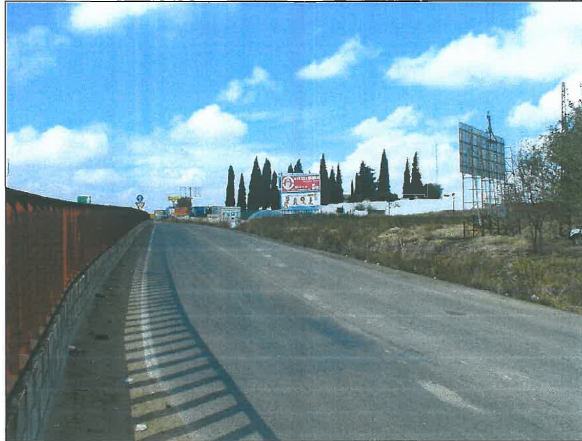
Fotograma N°12. Vial de servicio. Autopista A-49.
