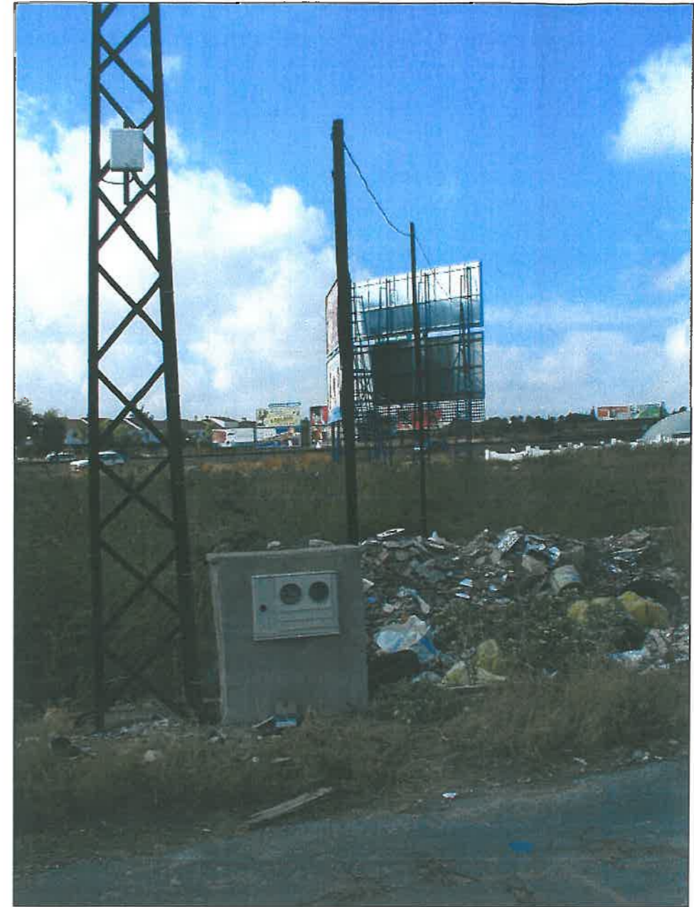
Fotograma N°10. C/ Virgen de Loreto. Acometida eléctrica del Cartel luminoso.
