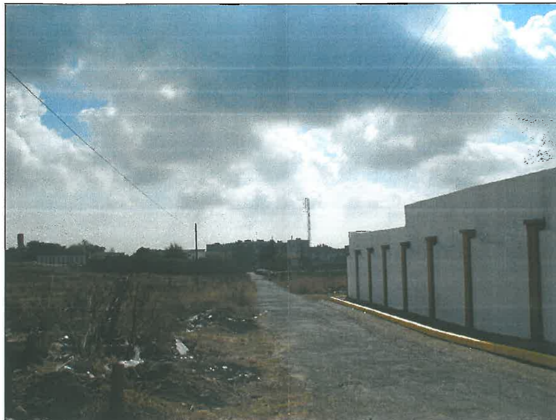
Fotograma Nº3. C/ Virgen de Loreto. Líneas aéreas de Teléfono y B.T.
