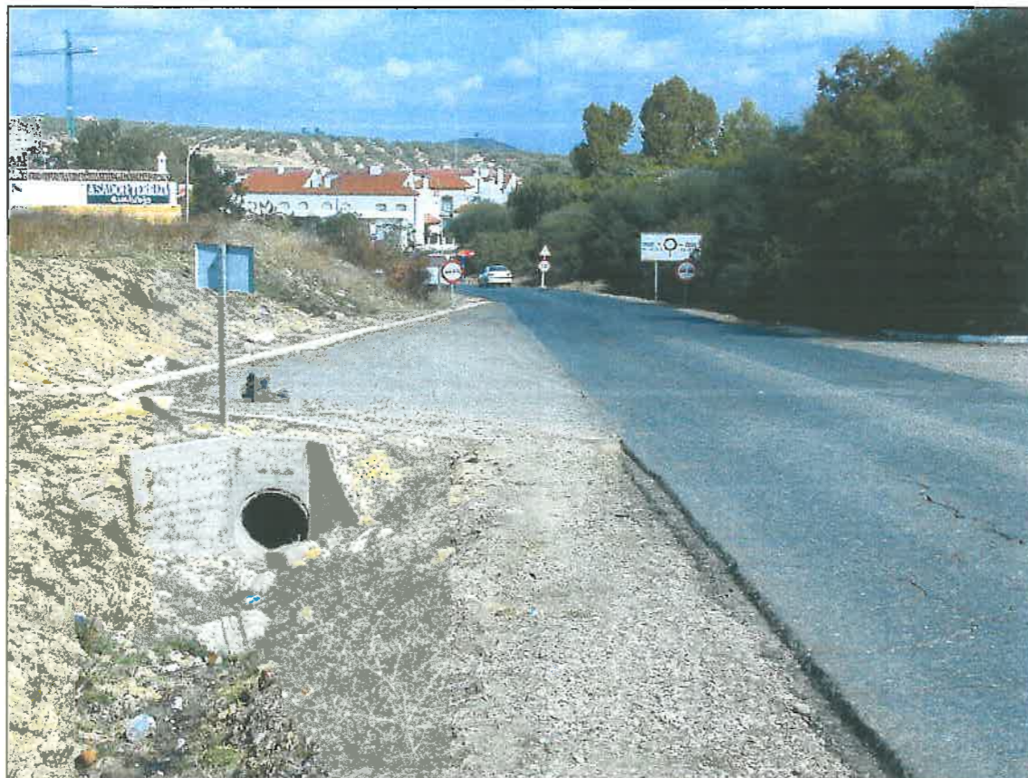
Fotograma N°20. Carretera de Tomares.
