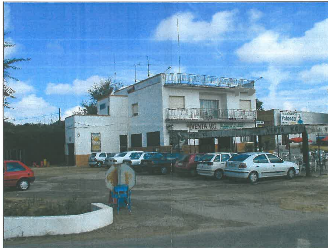
Fotograma N°14. Vial de servicio. Autopista A-49. Fachada Sur "Venta V.G."
