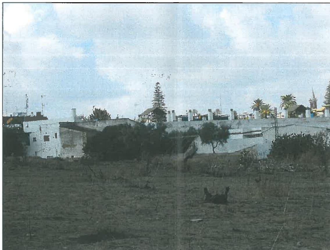
Fotograma N°36. Vista Noroeste del Sector. Fachada trasera C/ Diego de los Reyes.
