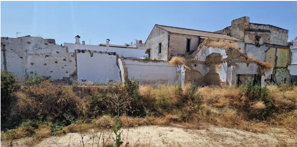
Muros medianeros tras demolición de antiguo Ayuntamiento
