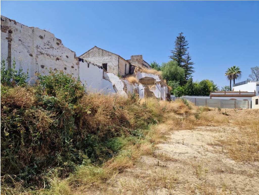
Muros medianeros tras demolición de antiguo Ayuntamiento
