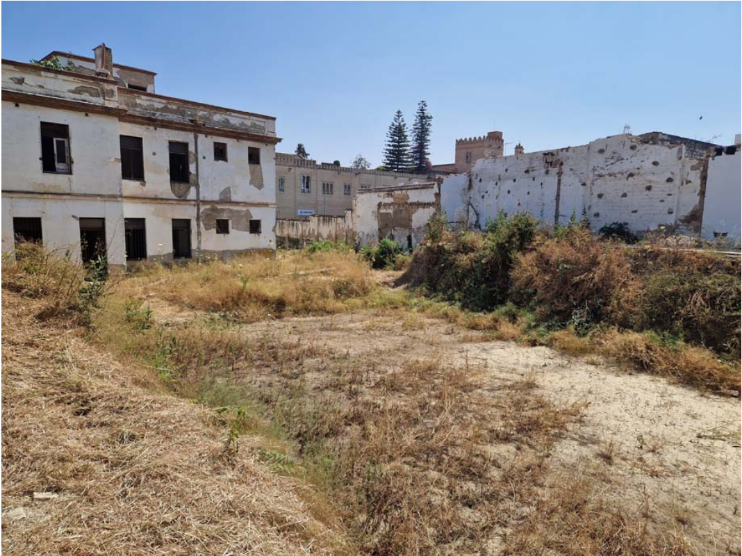
Trasera Chalet años 30 existente y medianeras colindantes tras demolición de antiguo Ayuntamiento
