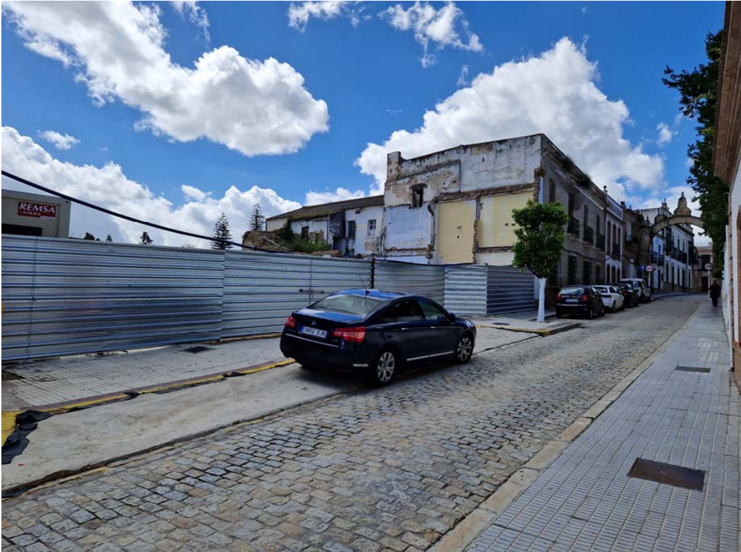
Parcela hacia calle Convento tras demolición de antiguo Ayuntamiento.
