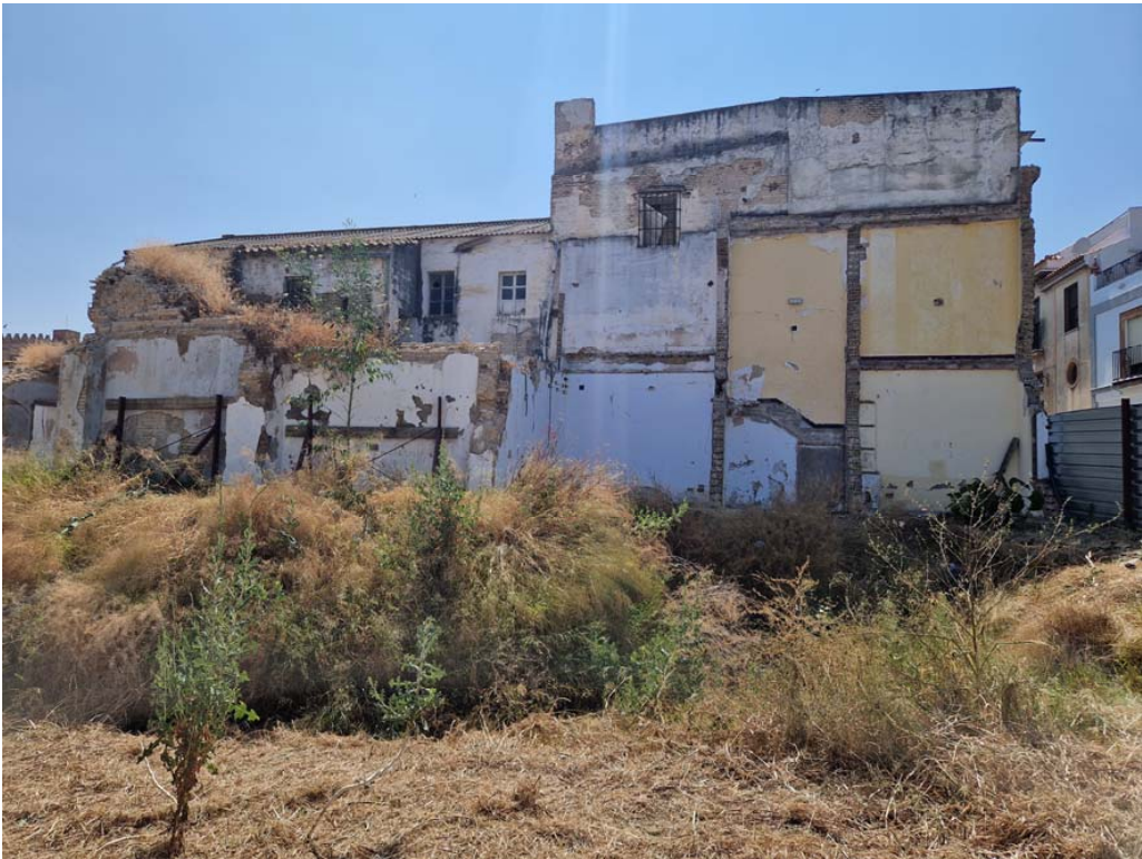
Muros medianeros tras demolición de antiguo Ayuntamiento
