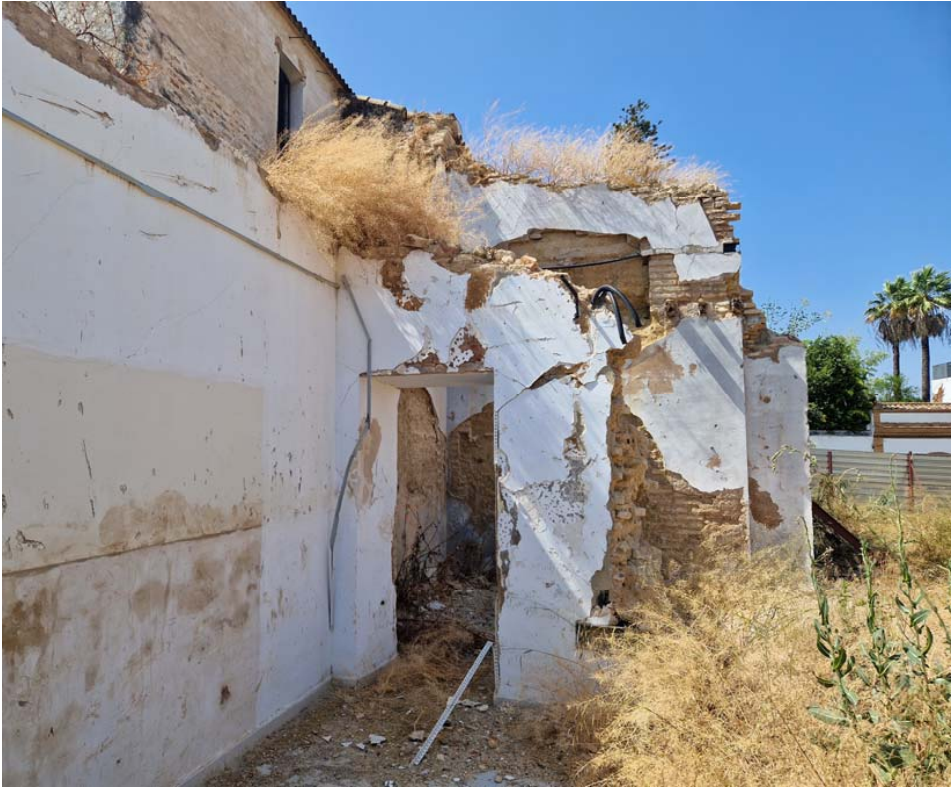
Muros medianeros tras demolición de antiguo Ayuntamiento
