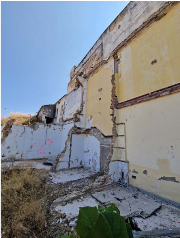
Muros medianeros tras demolición de antiguo Ayuntamiento
